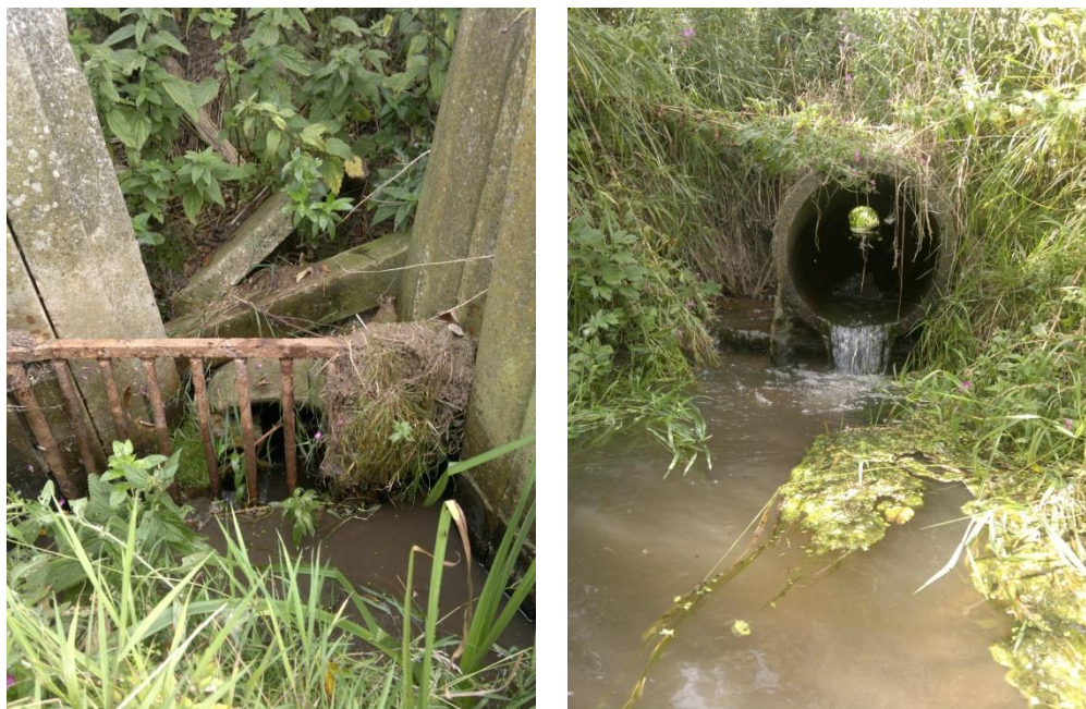
Figur 1.2: Foto af rørindløb og rørdløb for rørlægning AAL-1193. Foto taget den 26. august 2013.
